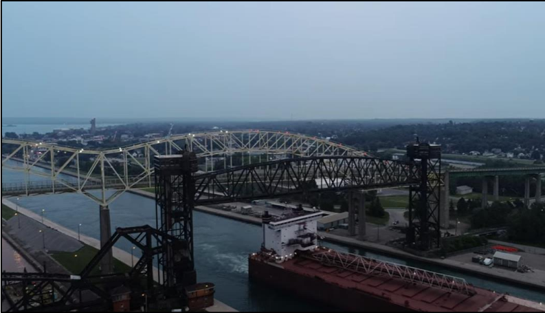
Figur 49: Dubbel lyftbro i Sault Ste. Marie, Michigan. Normalt öppnas bro för sjöfarten till i slutet av december eller mitten av januari.
