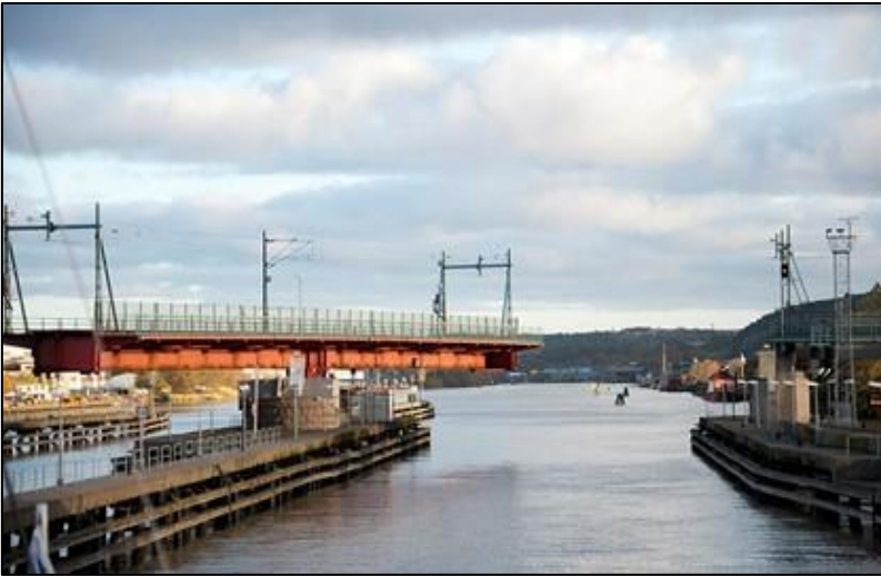
Figur 41: Järnvägsbro i Marieholm, en svängbro (Källa: Trafikverket)
